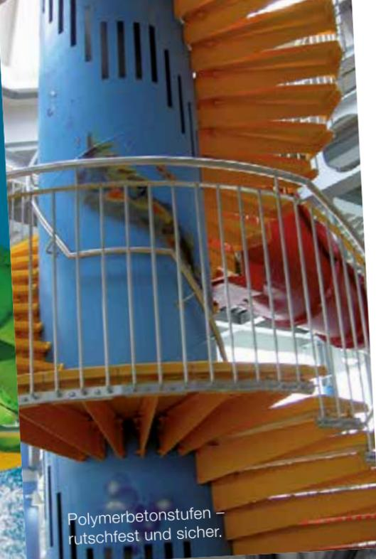
Polymerbetonstufen – rutschfest und sicher.
