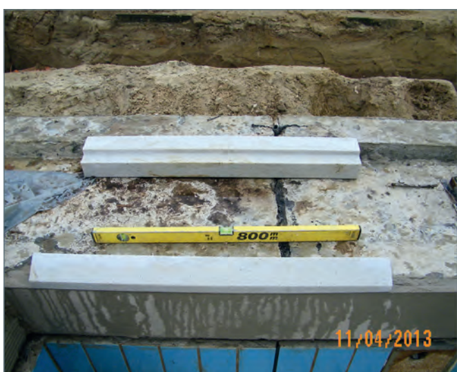
■ Polymerbetonformteile zur Beckenkopfausbildung
