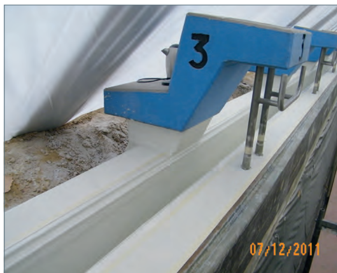
■ Ausbildung der Startblockanschlüsse
