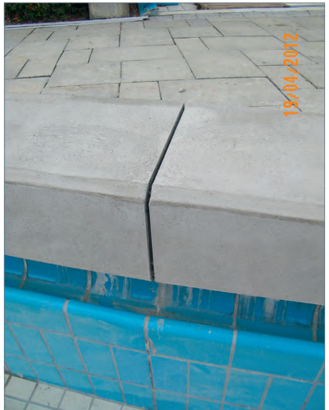
■ Modellierung des Beckenkopfes in Putztechnik und der Trennfuge
