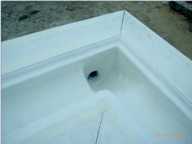
■ GFK-Bekleidung des Beckenkopfes
