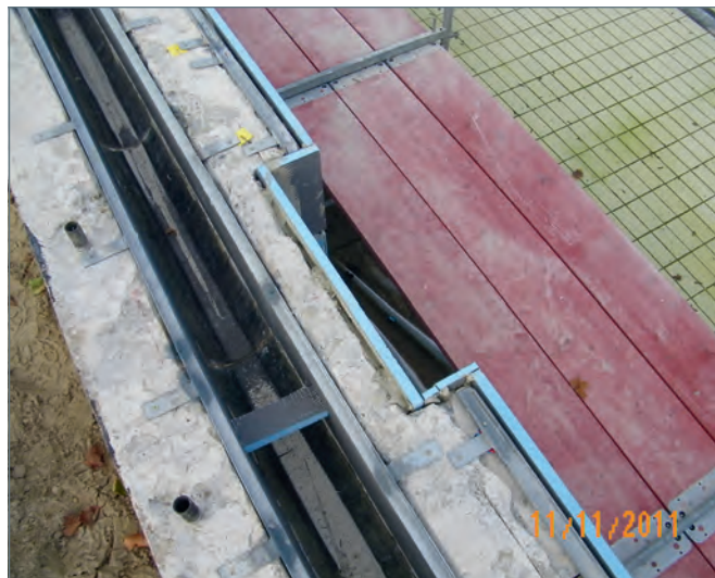
■ Hilfskonstruktion für Rinnenrostaufleger
