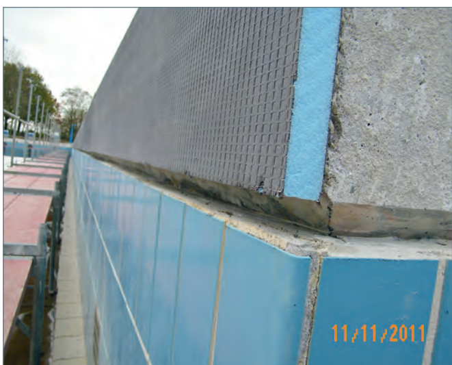
■ Isoliereinbefuge und XPS-Bekleidung
