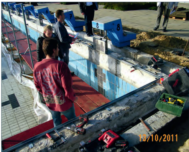
■ Abbruch- und Vorbereitungsmaßnahmen
