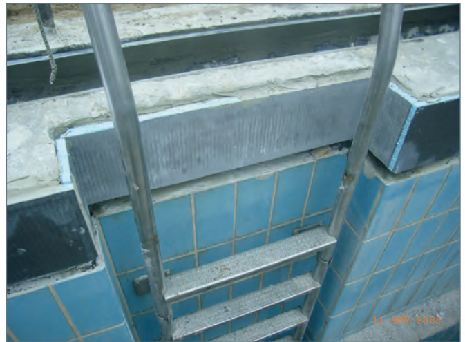
■ Ausbildung der Isoliereinbindefuge
